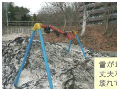
滑り台の滑る部分は、雪が堆積されると壊れやすい。
